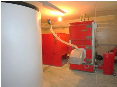
Die Heizung ist jetzt fertig installiert, alles fürs Warmwasser ist bereit. Jetzt kann das Heizsystem mit Wasser gefüllt werden und die Testphase wird folgen. Sobald wir Warmwasser brauchen, werden noch die Solarpanels montiert und angeschlossen. Der Strompreis in Moldawien ist sehr, sehr hoch (höher als bei uns). So sind wir froh, können wir die Sonnenwärme Moldawiens nutzen.
